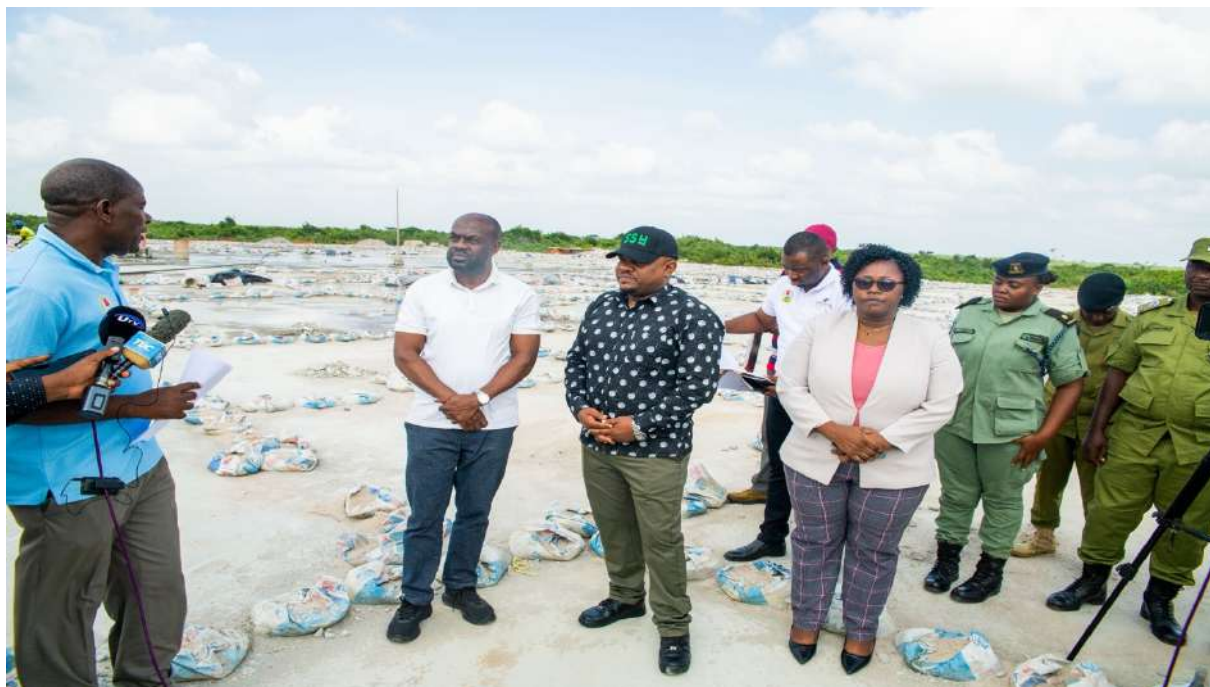
Naibu Katibu Mkuu Dkt Omary Hussein akikagua Ujenzi wa Mradi wa Kongani la Viwanda Kijiji cha Maranje Halmashauri ya Mji Nanyamba Mkoani Mtwara ukiendelea.
